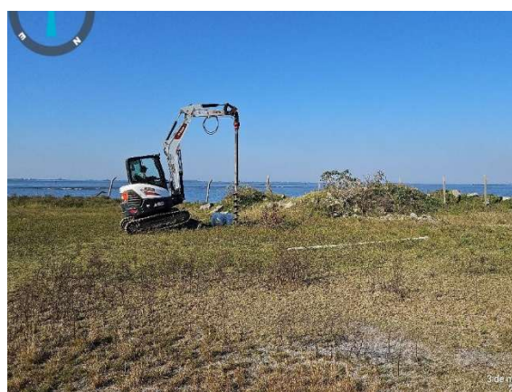
Foto 11. Perfuração com Mini Escavadeira E50 mecanizado.
