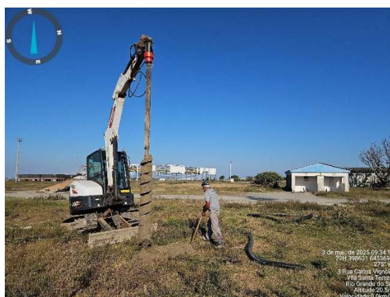
Foto 10. Perfuração com Mini Escavadeira E50 mecanizado.
