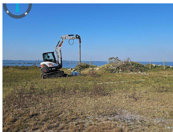
Foto 2. Perfuração com Mini Escavadeira E50 mecanizado.
